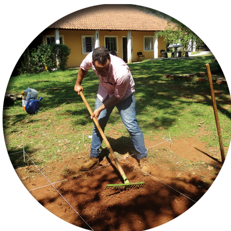
Figura 5: Retirada de pedras e detritos.
