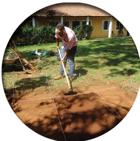
Figura 6: Compactação das bordas do canteiro.
