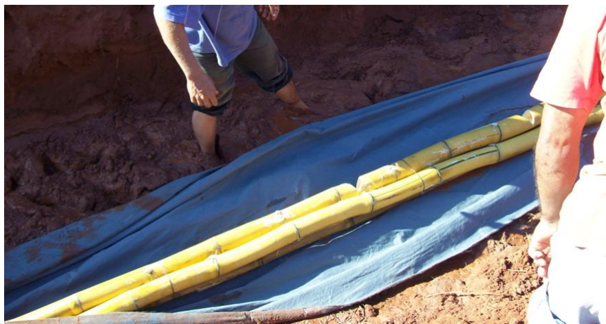
Foto 12. Instalação de drenagem profunda com feixes de bambu
