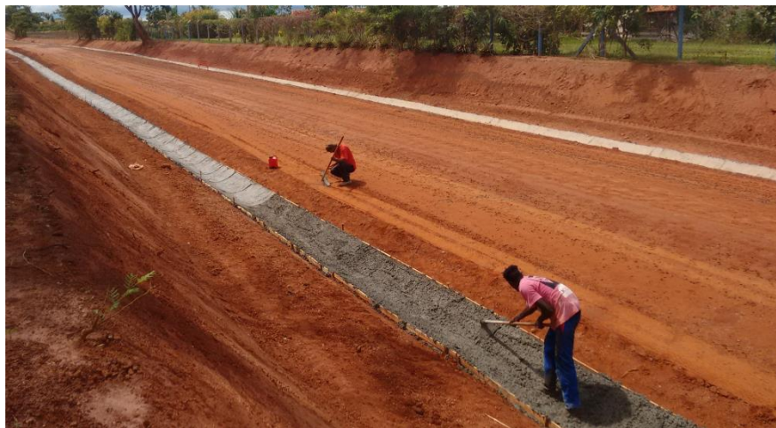
Execução de canaletas de concreto em estrada rural (Foto Arquivo Codasp)
