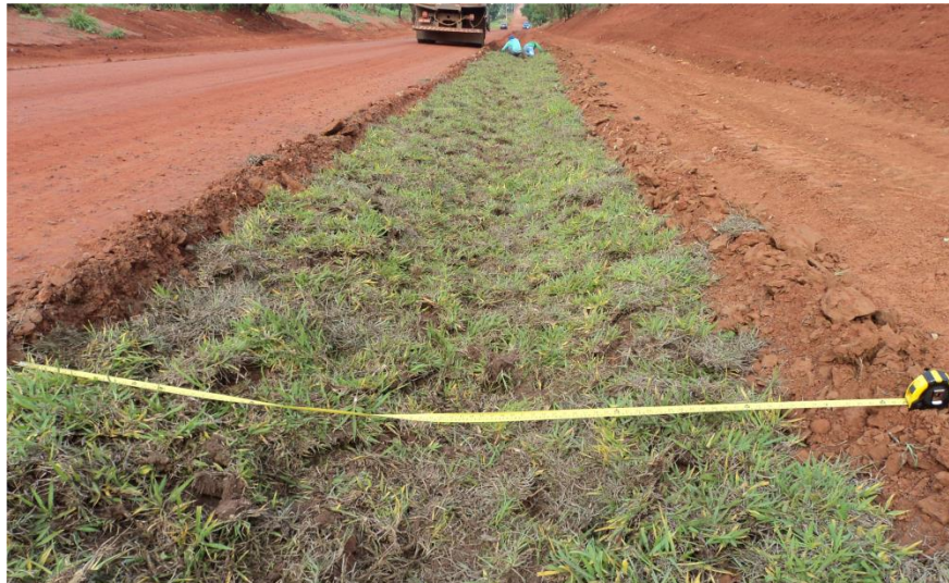
Execução de canaletas vegetadas em estrada rural (Foto Arquivo Codasp)
