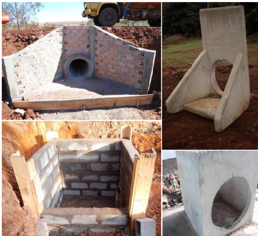
Alvenaria em blocos cerâmicos, de concreto e pré-moldados (Foto Arquivo Codasp)
