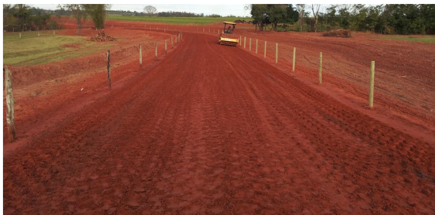
Foto 19: Trecho após execução da compactação, pronto para receber o acabamento (Fotos: Codasp - Regional Noroeste).
