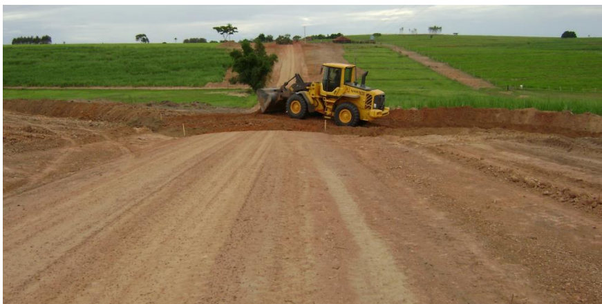
Construção de lombada (Foto Arquivo Codasp)
