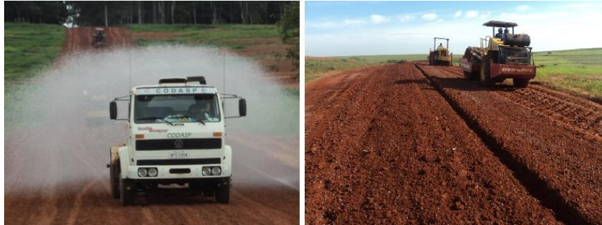
Umedecimento da mistura-solo brita e posterior compactação (Foto Arquivo Codasp)
