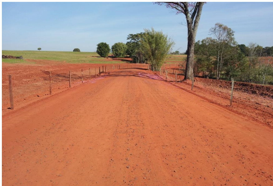
Trecho após conclusão do revestimento (Foto Arquivo Codasp)
