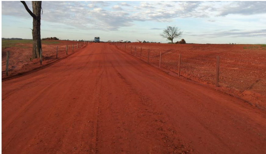
Trecho sendo "selado" com o auxílio de um caminhão irrigadeira (Foto Arquivo Codasp)
