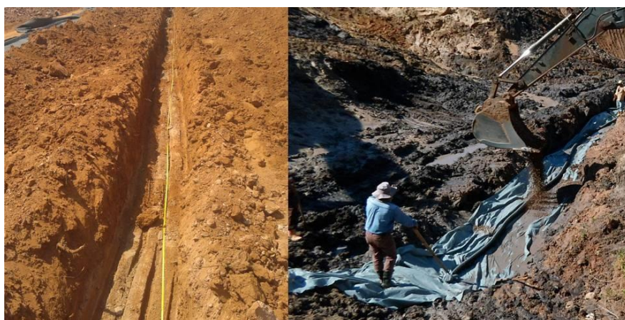
Foto 13. Abertura de vala e instalação de drenagem profunda
