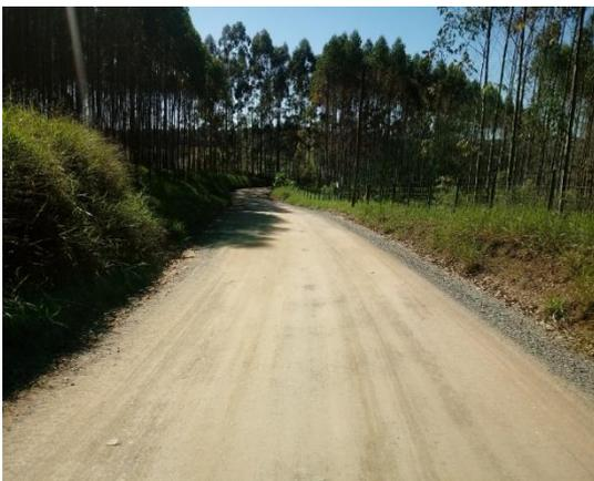
Estrada encaixada, sem saídas d'água
